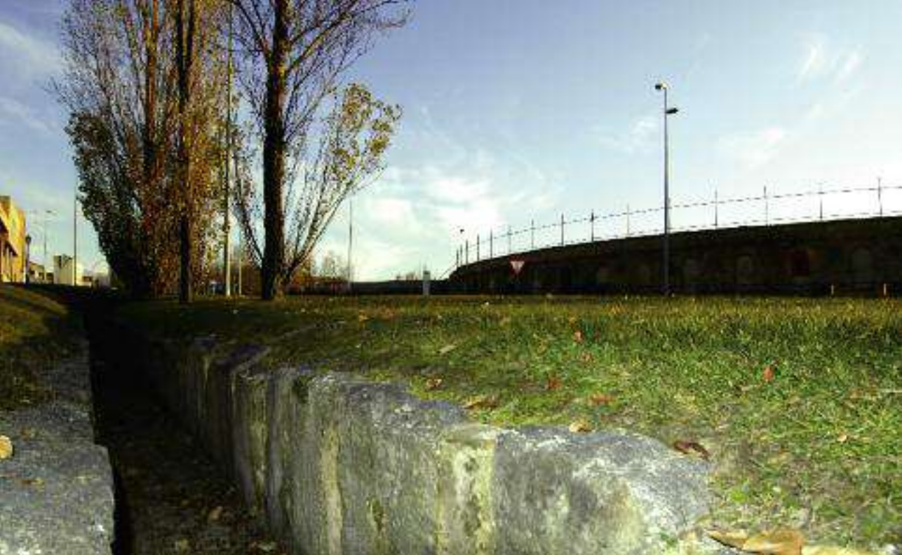
Canalización del Acueducto, junto a la carretera de La Granja
