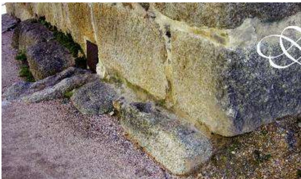
Restos de fábricas romanas en la base del segundo desarenador
